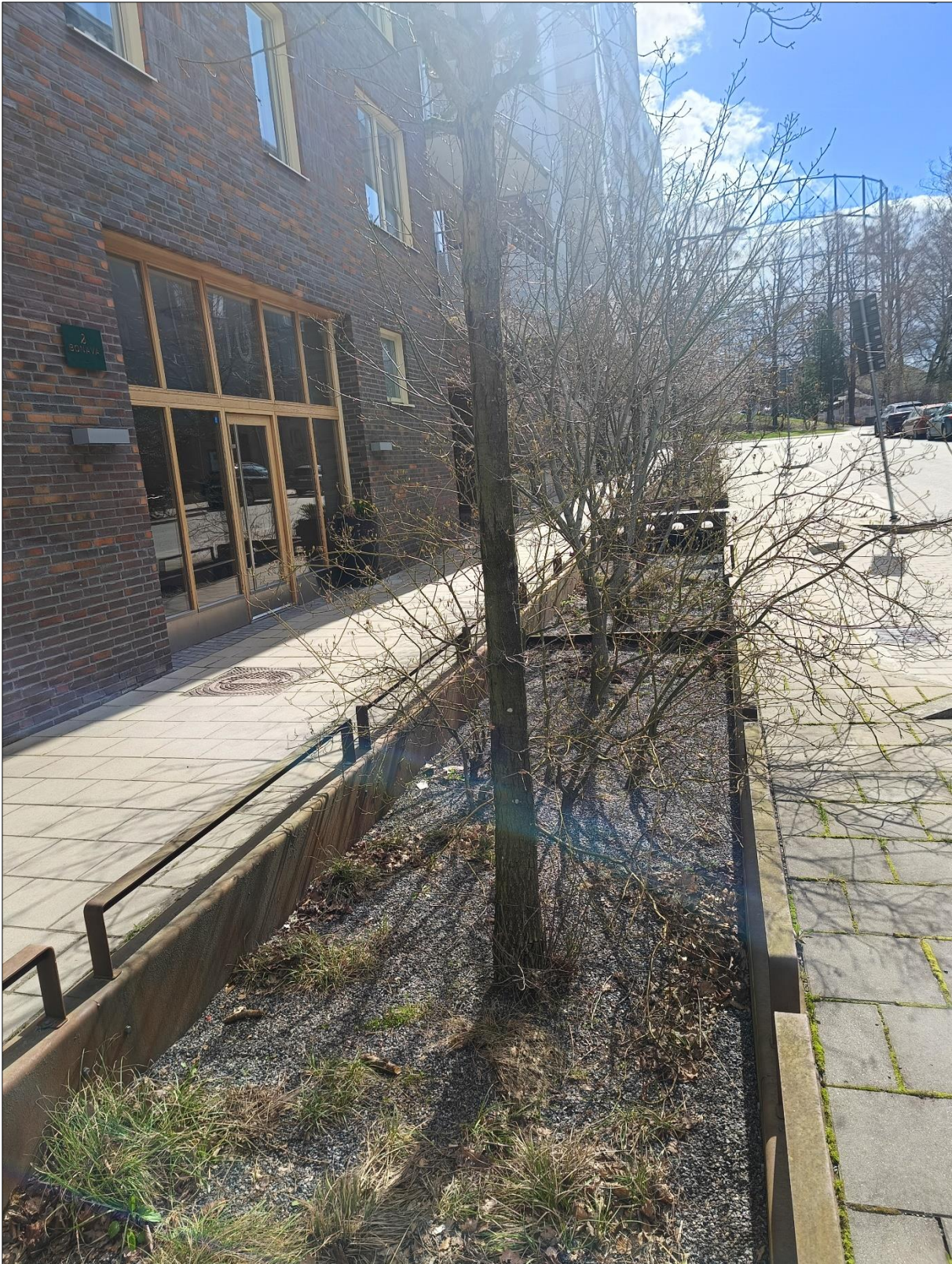
(6) Ogrody deszczowe w nowoczesnej dzielnicy Sztokholmu Energy Positive District.
